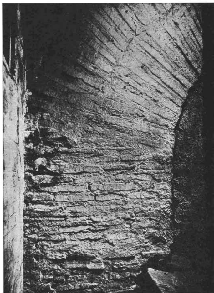
Fig. 72 — S. CECILIA - Finestra primitiva nel muro superiore destro della navata centrale.
